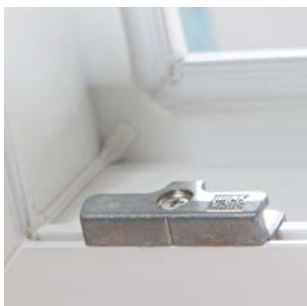
Schließbleche mit Hinterkrallung in der Standardausstattung
